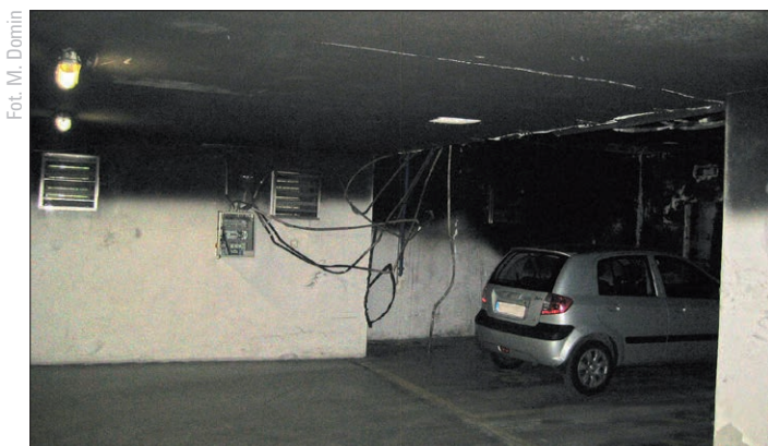
Fot. 2. Nawet niewielki pożar generuje natychmiast ogromną ilość produktów spalania. Wszelkie urządzenia systemu detekcji są narażone na kontakt z nimi, co powoduje uniemożliwienie pomiarów i często uszkodzenie samych elementów sensorycznych
